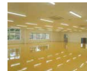
社会福祉法人施設作業場 新築電気工事 2020年6月施工
