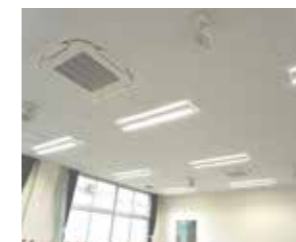
穎娃中学校特別教室 空調整備工事 2021年5月施工
