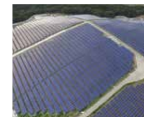
太陽光発電所電気設備工事 2019年11月施工
