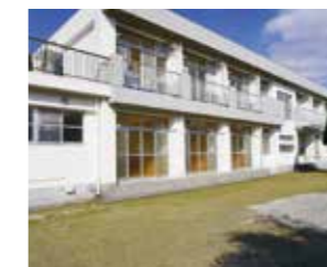
薩南工業高校大規模改修工事 (寄宿舎・電気) 2020年11月施工
