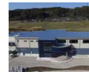
工場建設工事(電気工事) 2019年10月施工
