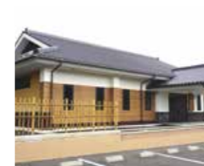
納骨堂新築電気工事 2021年4月施工
