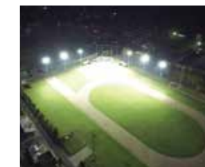
平和公園陸上競技場 ナイター照明工事 2019年10月施工
