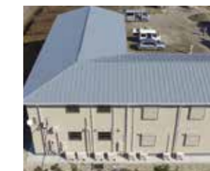
宿舎建設工事(電気工事) 2019年1月施工
