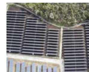
太陽光発電所電気設備工事 2020年11月施工
