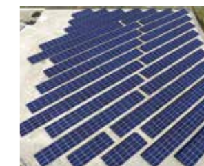
太陽光発電所パネル増設工事 2018年10月施工
