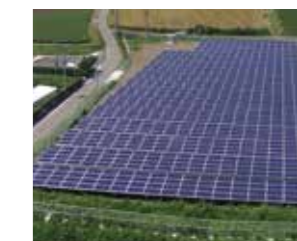
太陽光発電所電気設備工事 2018年3月施工
