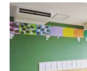
知覧地域小学校空調整備工事 2019年9月施工
